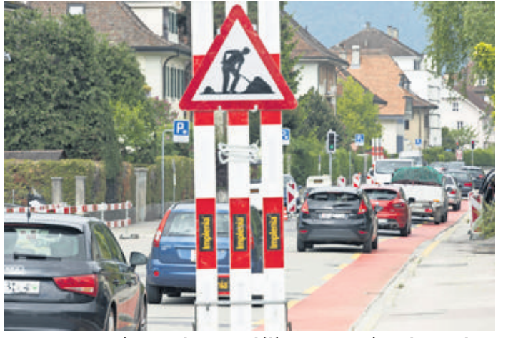
Les travaux préparatoires ont déjà commencé sur la rue du Midi. PHOTO JEAN-PAUL GUINARD
