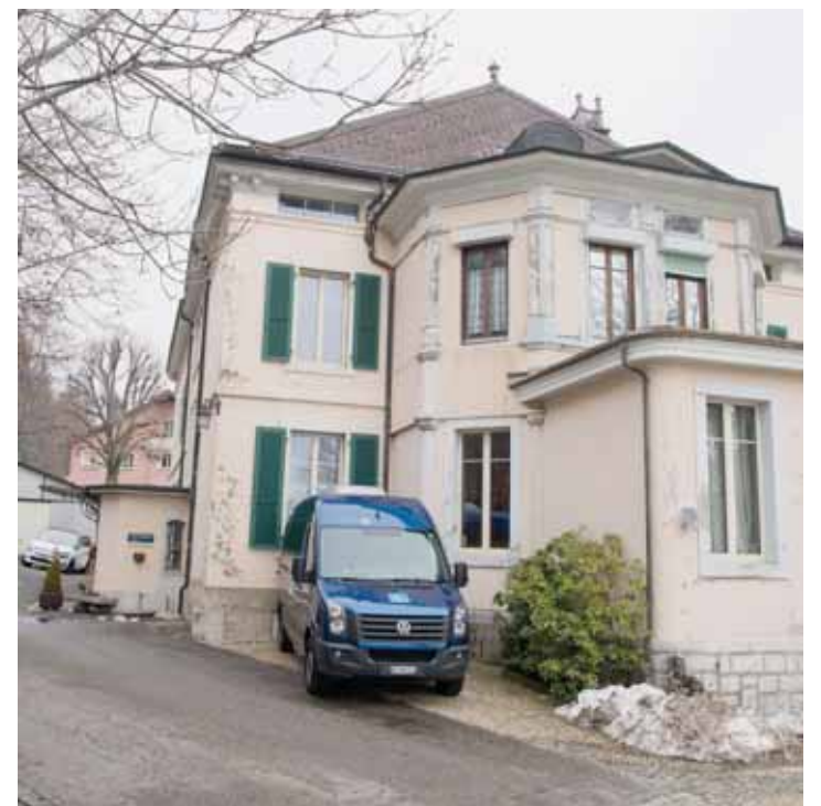
En mars, des travaux de rénovation devraient commencer au home Vert-Bois. Ils sont prévus pour une durée de six mois. DAVID MARCHON
